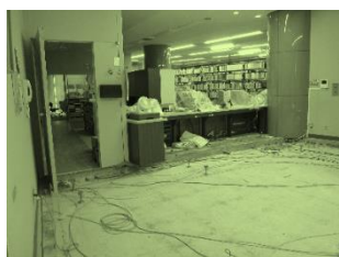
▲工事中の事務室内の様子
